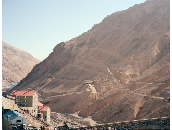
Fig. 3 El Teniente underground copper mine, Comuna de Machalí, Atacama, Chile (Acosta 2014).
