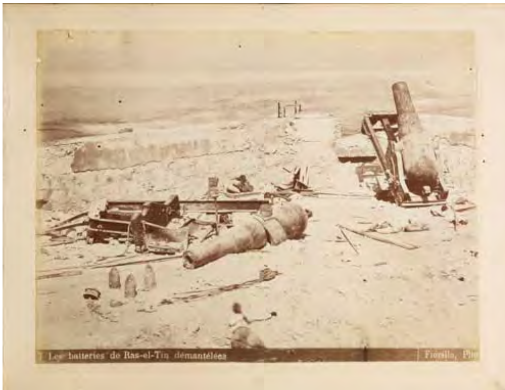
Figure 9. Les batteries de Ras-el-Tin démantelées by L. Fiorillo
